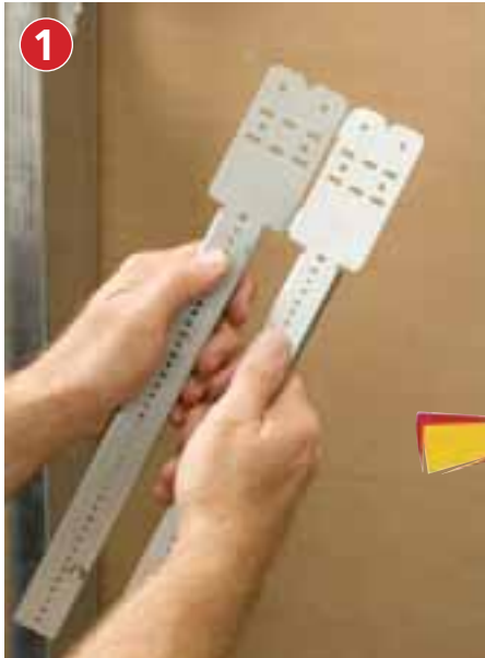
1. Doble el soporte telescópico TSGB por la muesca.
